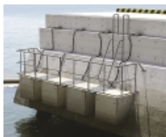
刈田港における暴露実験の様子
